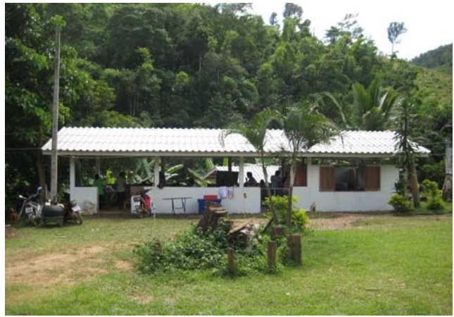
- ปรับปรุงอาคารสี่โรงครัว (After)
